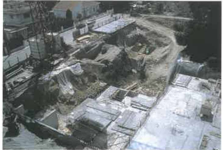
Vue du site depuis la grue (photo D. Binder)
