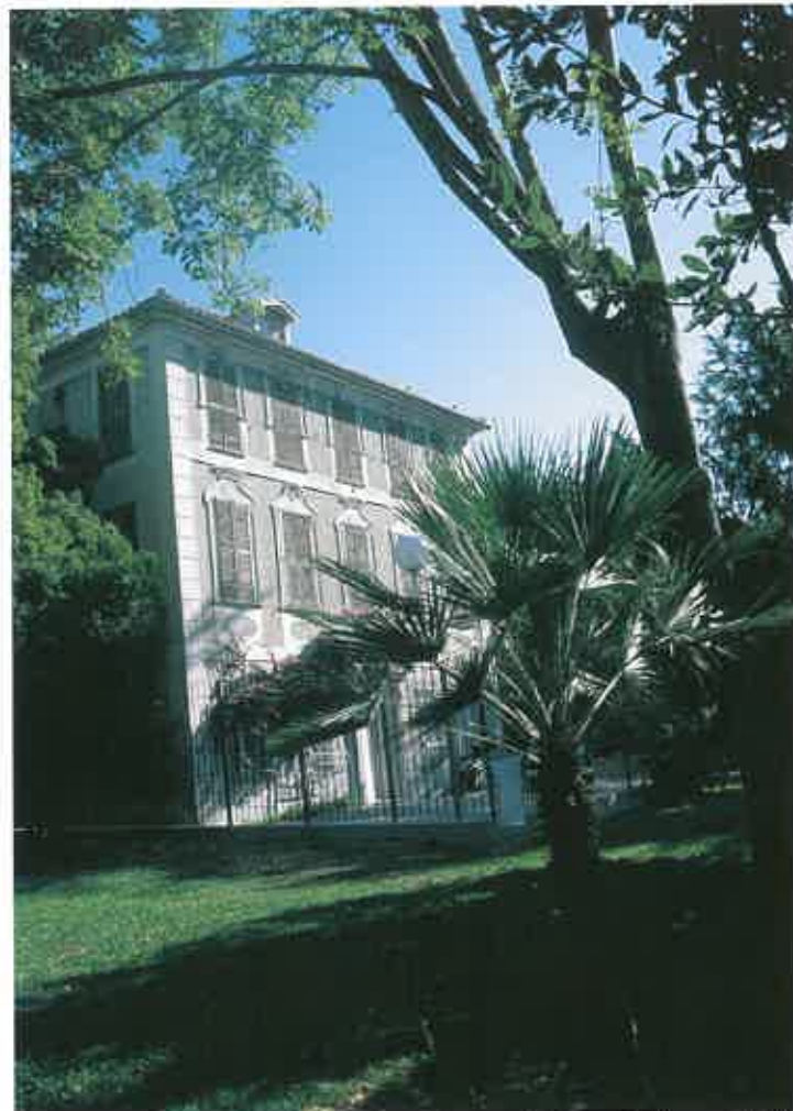
La villa Giribaldi. Actuellement villa Ratti (du nom de l'avenue), elle accueille les services du 3 ème territoire (Trois collines) de la ville de Nice
